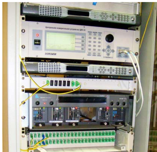
Мультиплексор Prostream 1000 в УФЕ «МТУ Кристалл»
